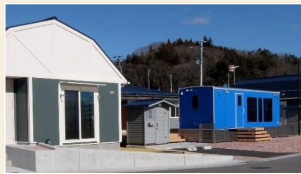
写真上：村営復興住宅「深谷団地」 （2018 年竣工） 写真右上：太陽光発電施設（2015 年完成） 写真右：花き栽培施設（2018 年完成）
