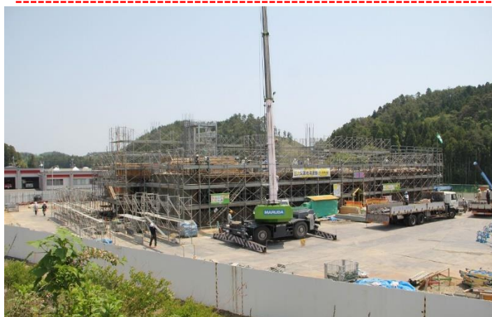
(建設中の南三陸署。左奥は南三陸消防署＝6 月撮影)
