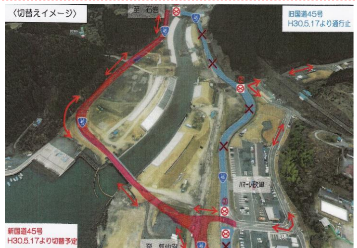
(復旧工事で切り替えになった伊里前の国道45号線)
