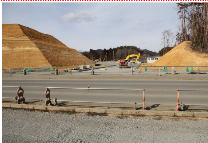
（工事が進む南三陸海岸ICへの取り付け道路）
