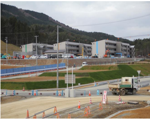
(完成間近の戸倉地区災害公営住宅)
