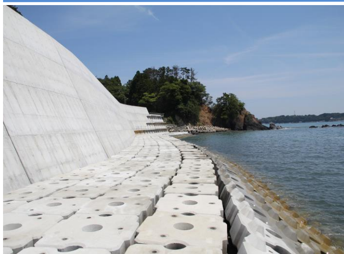
(順調に工事が進む館浜地区の海岸防潮堤)
