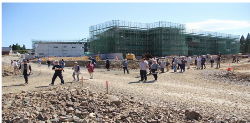
(中学校上団地の造成地を見学する参加者。奥は災害公営住宅)
