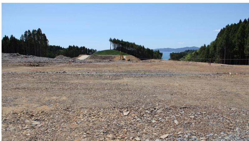
(柘沢団地の造成工事現場)
