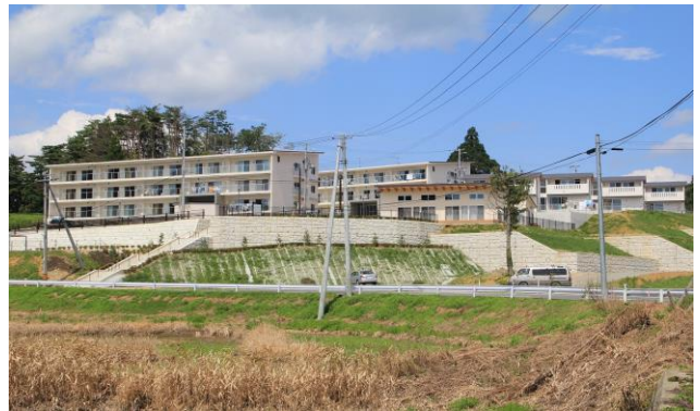
(名足の災害公営住宅の全景、8月20日撮影)
